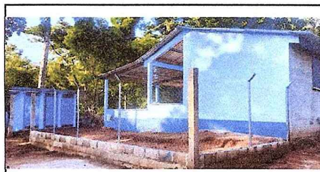
Foto 4: Finalizacion de la colocacion de la mayan
