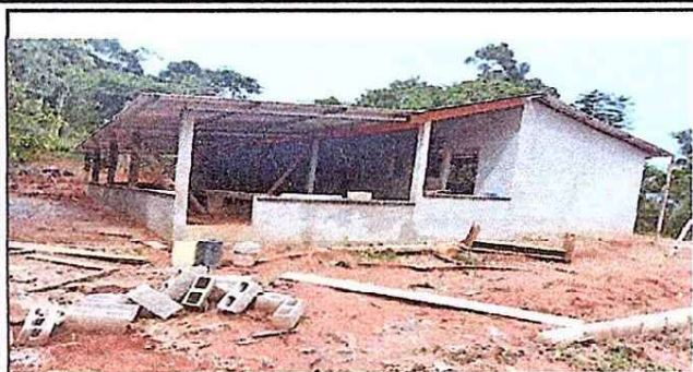
Foto1: finalizacion del entechado
